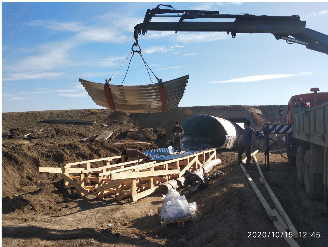
Рисунок 2. Монтаж КМГС [материал автора]
