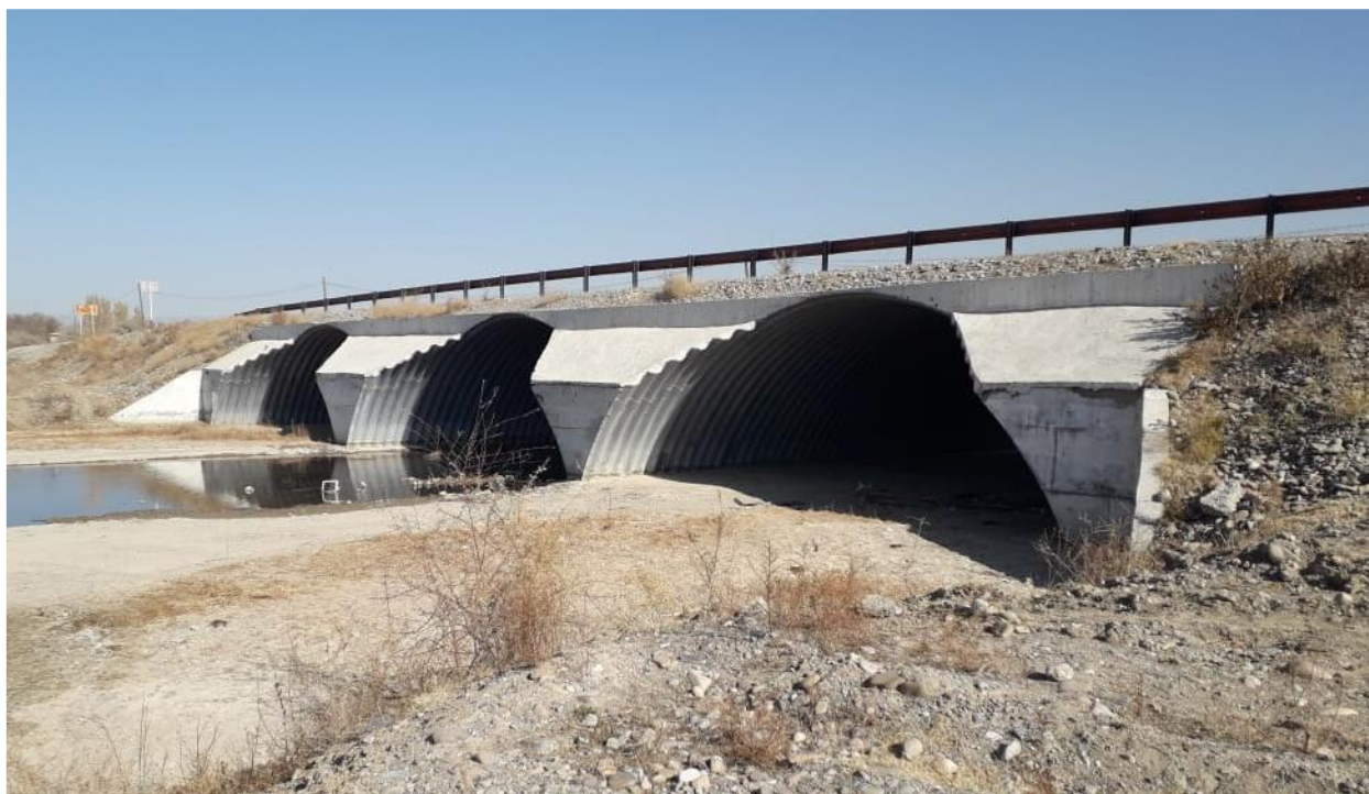
Рисунок 6. Решение по капитальному ремонту малого моста, по схеме 3х14,45м, общей длиной 43,1м [материал автора]
