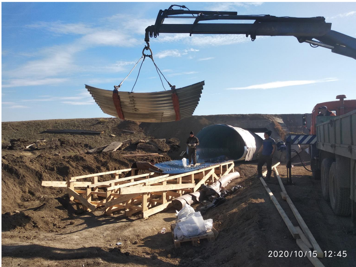
Рисунок 2. Монтаж КМГС [материал автора]
