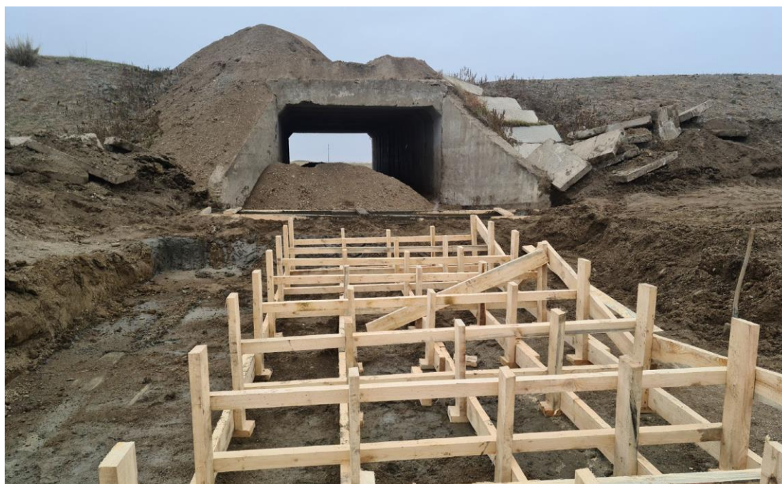
Рисунок 1. Разборка укрепления дна, устройство основания и монтаж стапеля, из деревянного бруса, для сборки и передвижки КМГС [материал автора]
