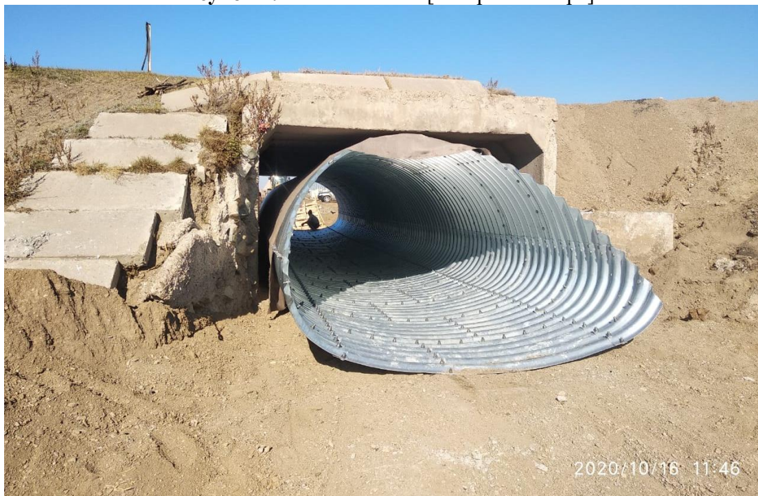
Рисунок 3. КМГС установлена в проектное положение [материал автора]
