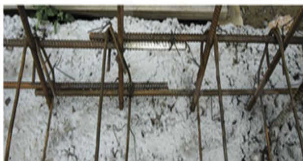
Рисунок 1. Соединение арматуры внахлест методом связки [9]
