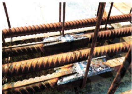
Рисунок 2. Соединение арматуры методом сварки [9]
