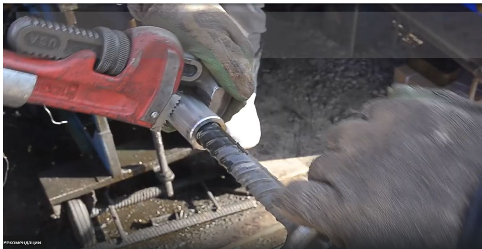
Рисунок 4. Монтаж арматуры методом механического соединения (муфт) [материалы автора]
