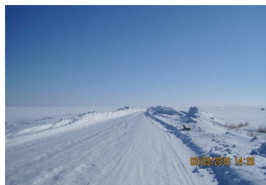
Рисунок 1. Образование снежного наката на автодорогах, проходящие степной местности (Восточный Казахстан) [3]
