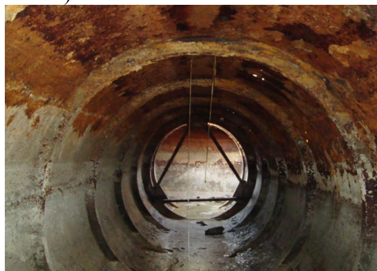
Рисунок 4. Образование коррозии в металлических резервуарах и трубопроводах [материал автора]
