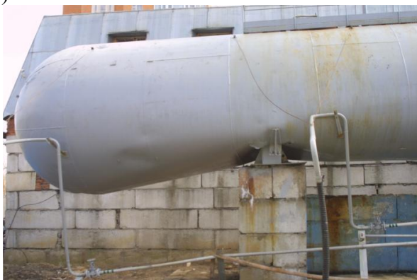
Рисунок 4. Образование коррозии в металлических резервуарах и трубопроводах [материал автора]
