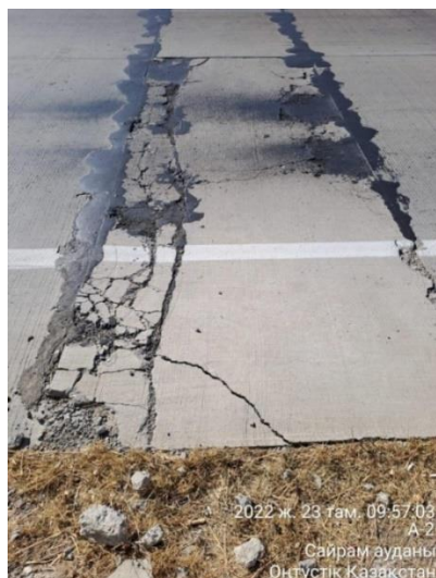
Рисунок 2. Типовые виды дефектов на цементобетонном покрытии [материал автора]
