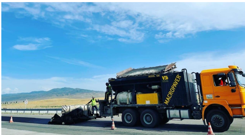
Рисунок 7. Укладка ЛЭМС [материал автора]
