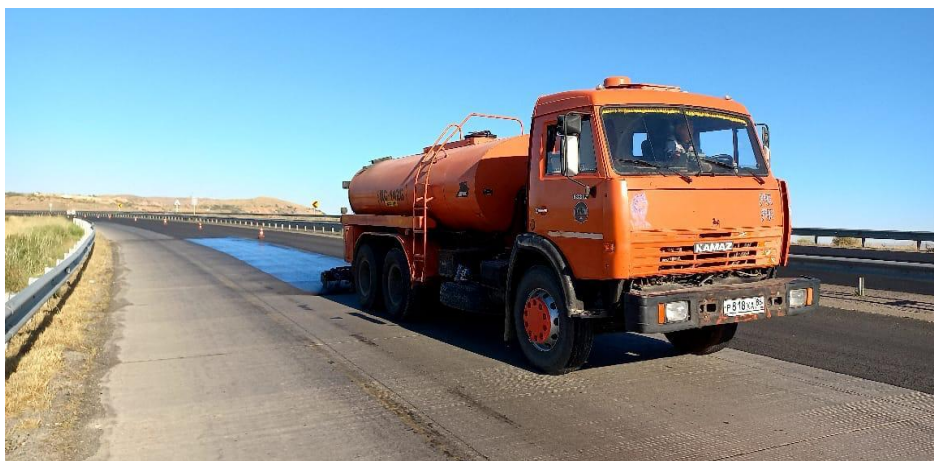
Рисунок 6. Розлив вяжущих материалов [материал автора]
