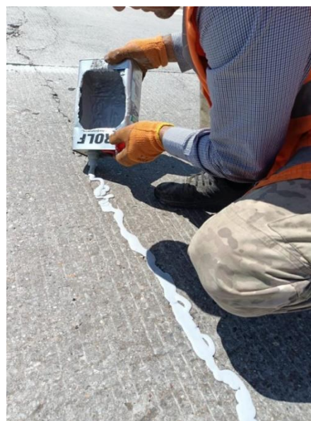
Рисунок 3. Устранение дефектов на цементобетонном покрытии [материал автора]
