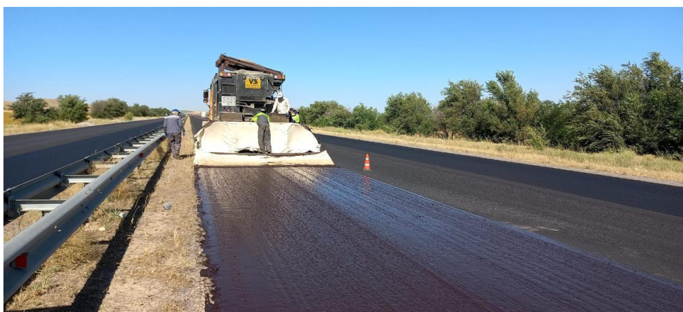
Рисунок 8. Укладка ЛЭМС [материал автора]
