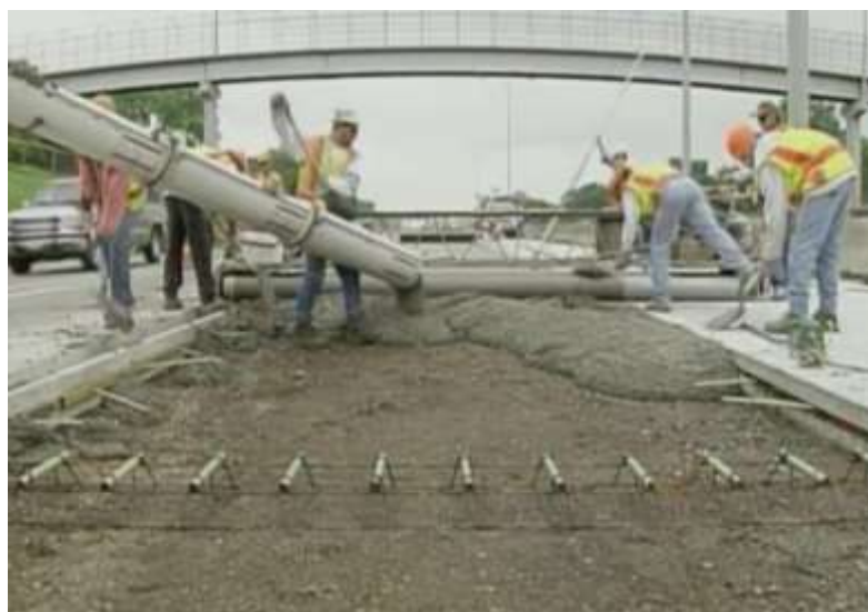
Рисунок 4. Зарубежный метод ремонта - полная замена цементобетонной плиты покрытия [8]
