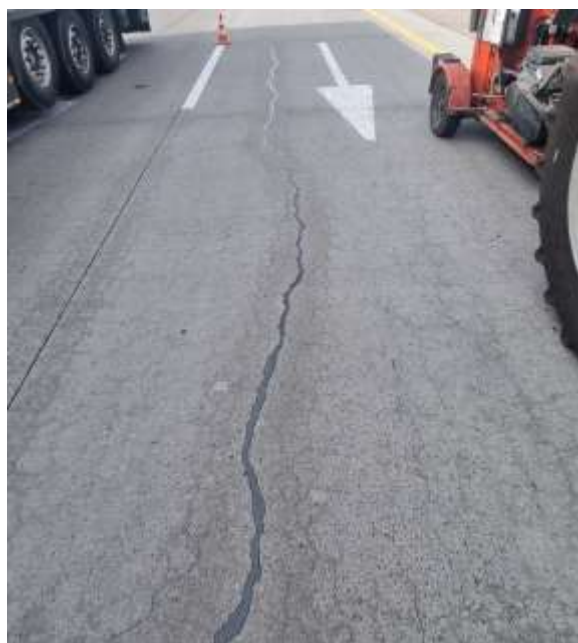
Рисунок 7. Герметизация трещин (опытный участок) [собственный материал]
