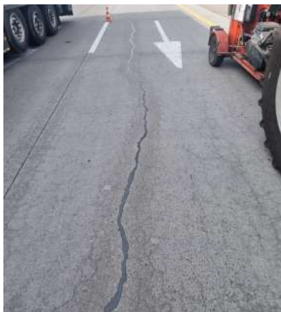
Рисунок 7. Герметизация трещин (опытный участок) [собственный материал]
