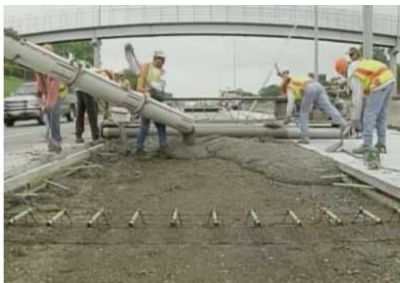
Рисунок 4. Зарубежный метод ремонта - полная замена цементобетонной плиты покрытия [12]
