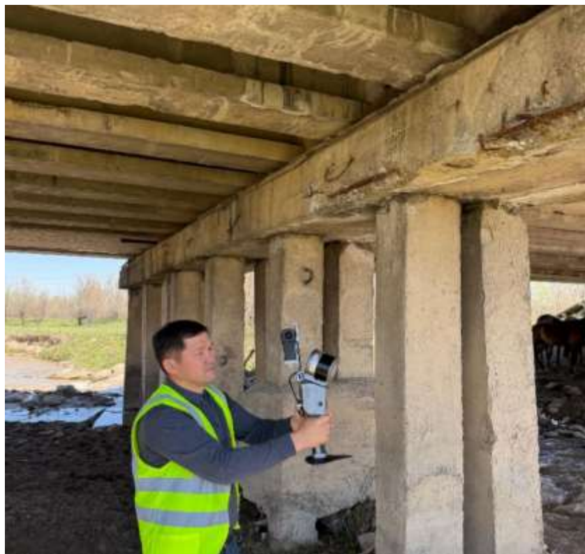
Рисунок 6. Инструментальное обследование мостового сооружения с использованием мобильного лазерного сканирования [материал автора]
