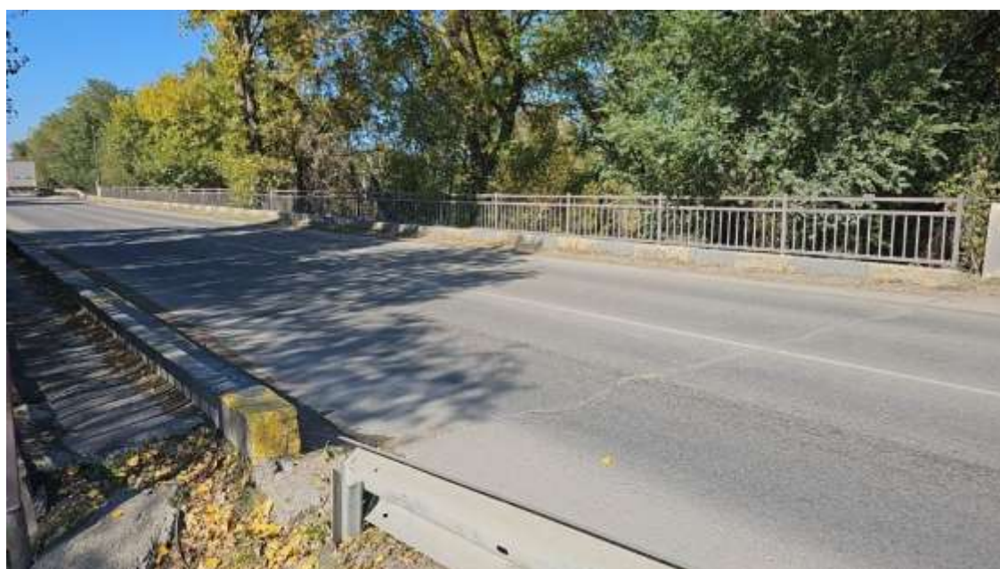
Рисунок 1. Мост через р. Аксай на км 48+900 автомобильной дороги KZ05-10. Общий вид проезжей части моста и подходов [материал автора]
